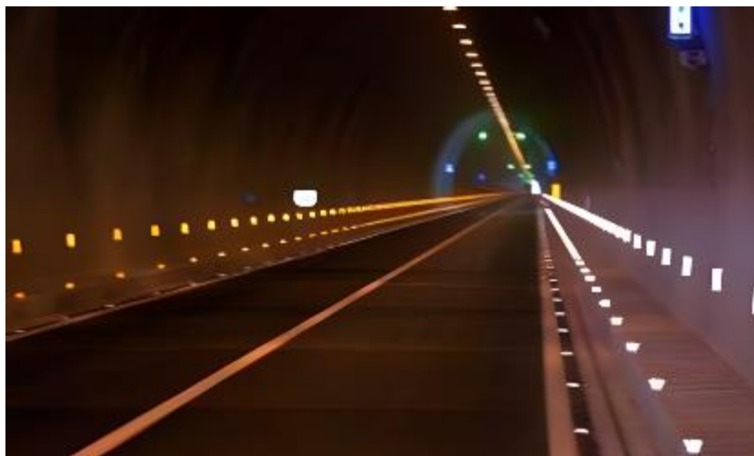
图 4.1-3 车行道边缘线外侧发光道钉示例图
