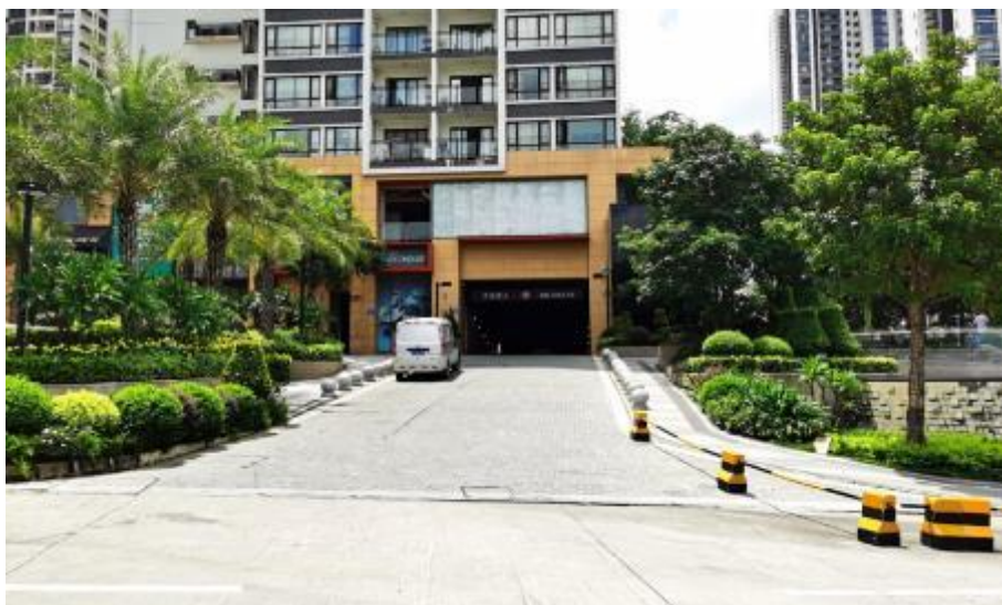
图 7.2-2 汽车坡道出入口
