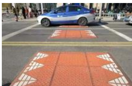
图 4.1-8 静化缓速垫示例图
